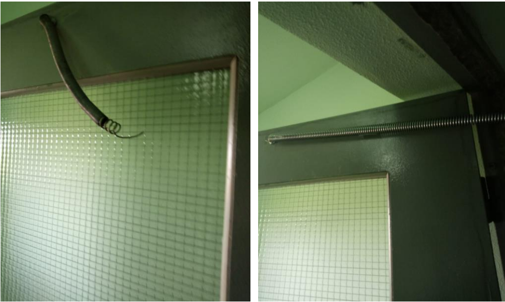
7) 05.10.23 На 10-м этаже замена пружины у двери переходной лоджии
