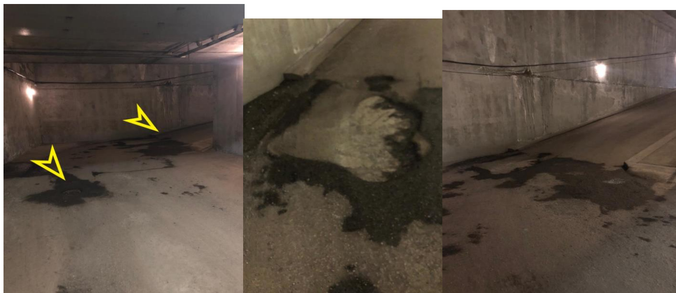
6) 18.10.23 Восстановление асфальтового покрытия в паркинге, где выезд нулевой уровень.
